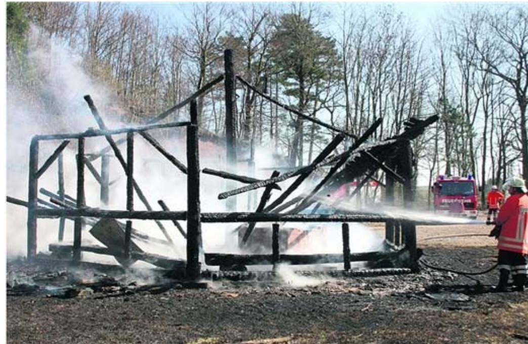
Feuerwehrkräfte löschen die Reste der Schutzhütte.
