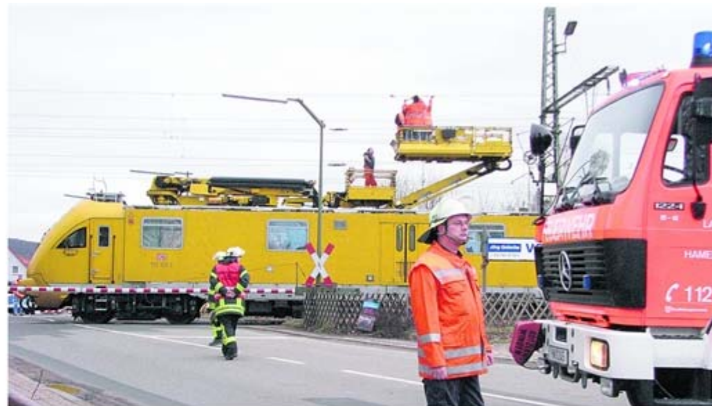
Ein Spezialtrupp der Bahn repariert die Oberleitung, die Feuerwehr sichert den Unfallort.
